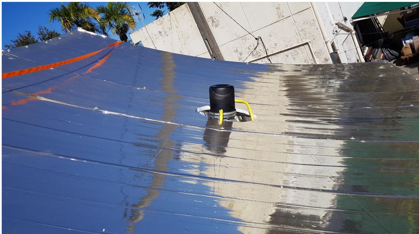
**Photo 2** : le convertisseur thermodynamique et ses 40% de rendement électrosolaire ayant produit 10kWc, fonctionnant soit avec le soleil concentré, soit avec le « solar fuel » la nuit ou par temps couvert.
