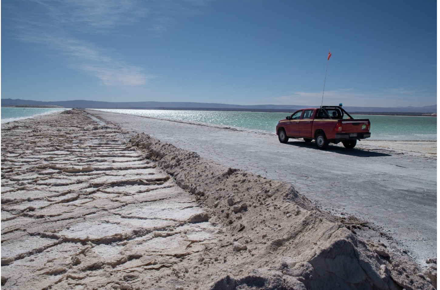
Bassins de saumure de lithium dans le désert d'Atacama
