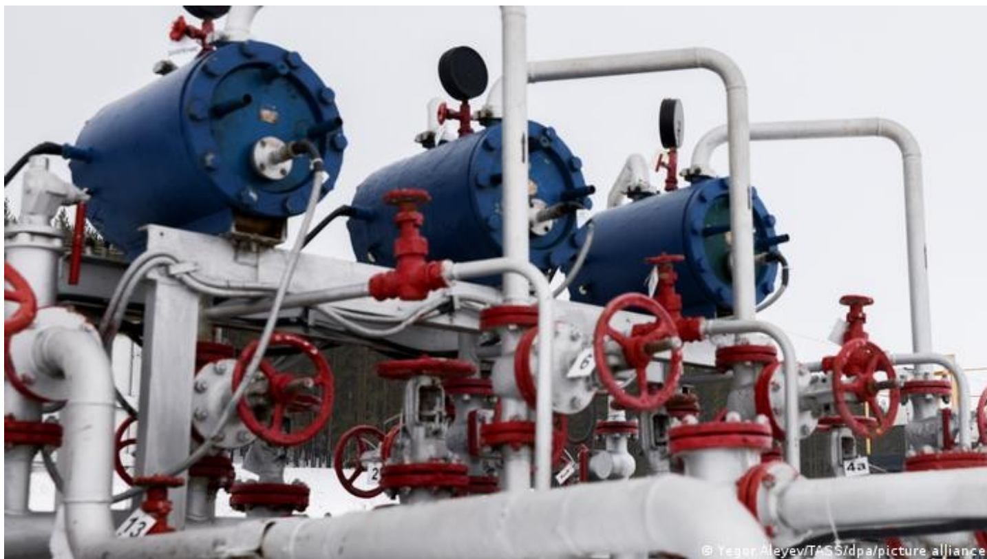
Installation de gaz russe
