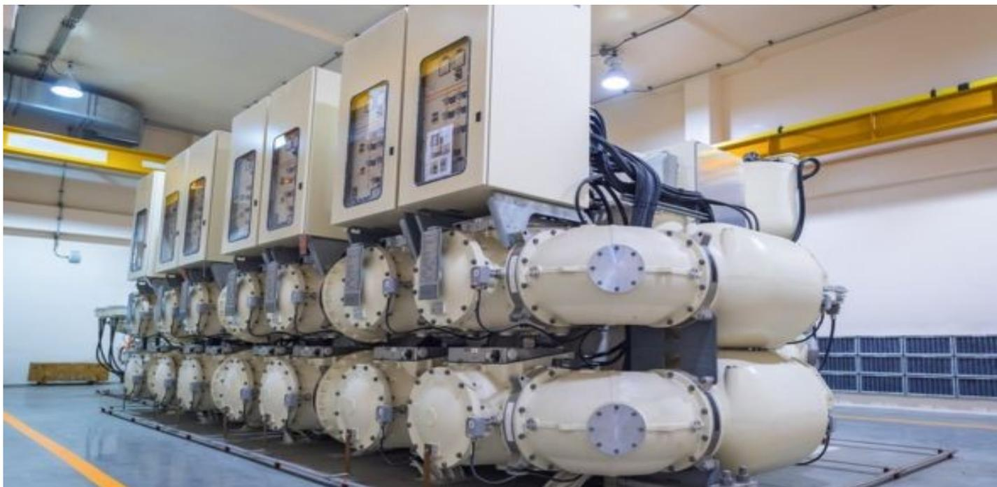
***Les appareillages de commutation haute tension à isolation gazeuse utilisent presque toujours du SF6***
