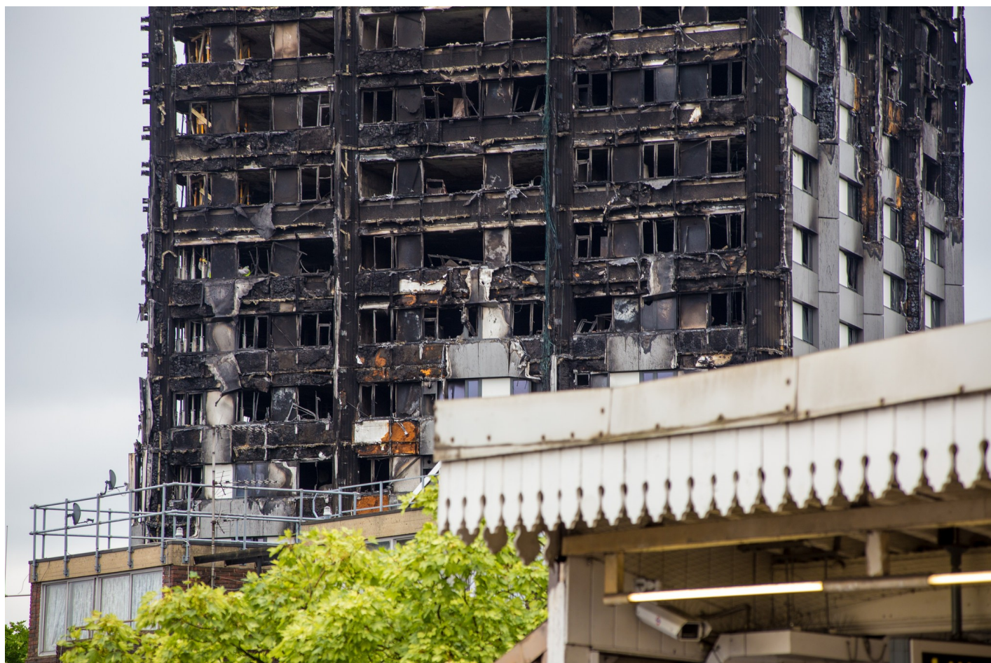
Tour Grenfell après l'incendie
