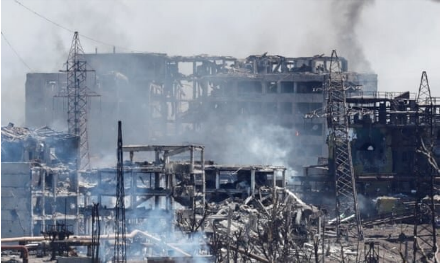
L'ancienne usine sidérurgique Azovstal à Mariupol. L'UE estime que les dommages causés aux seules infrastructures physiques pourraient s'élever à plus de 100 milliards d'euros (Photo : Alexander Ermochenko/Reuters)
